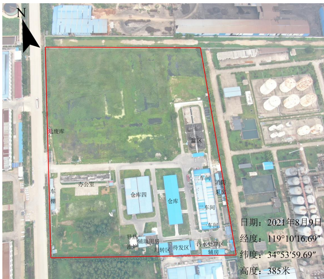
图 2.3-1 地块航拍影像图
