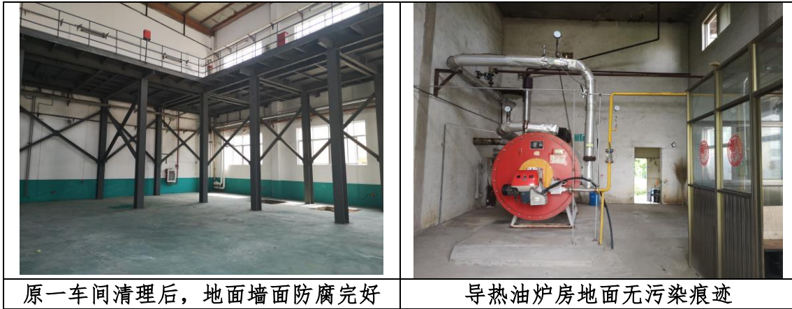
图 4.1-1 现场踏勘照片
