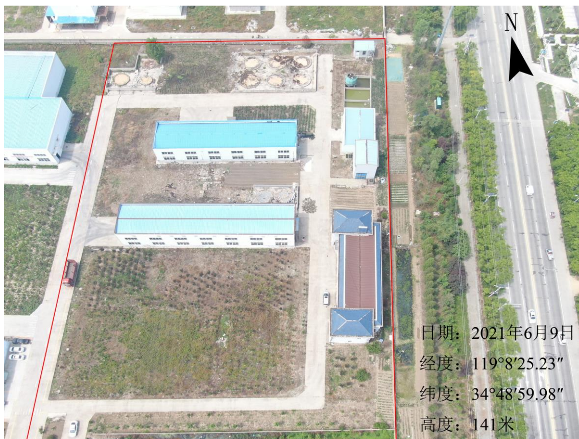
图 2.3-1 地块航拍影像图
