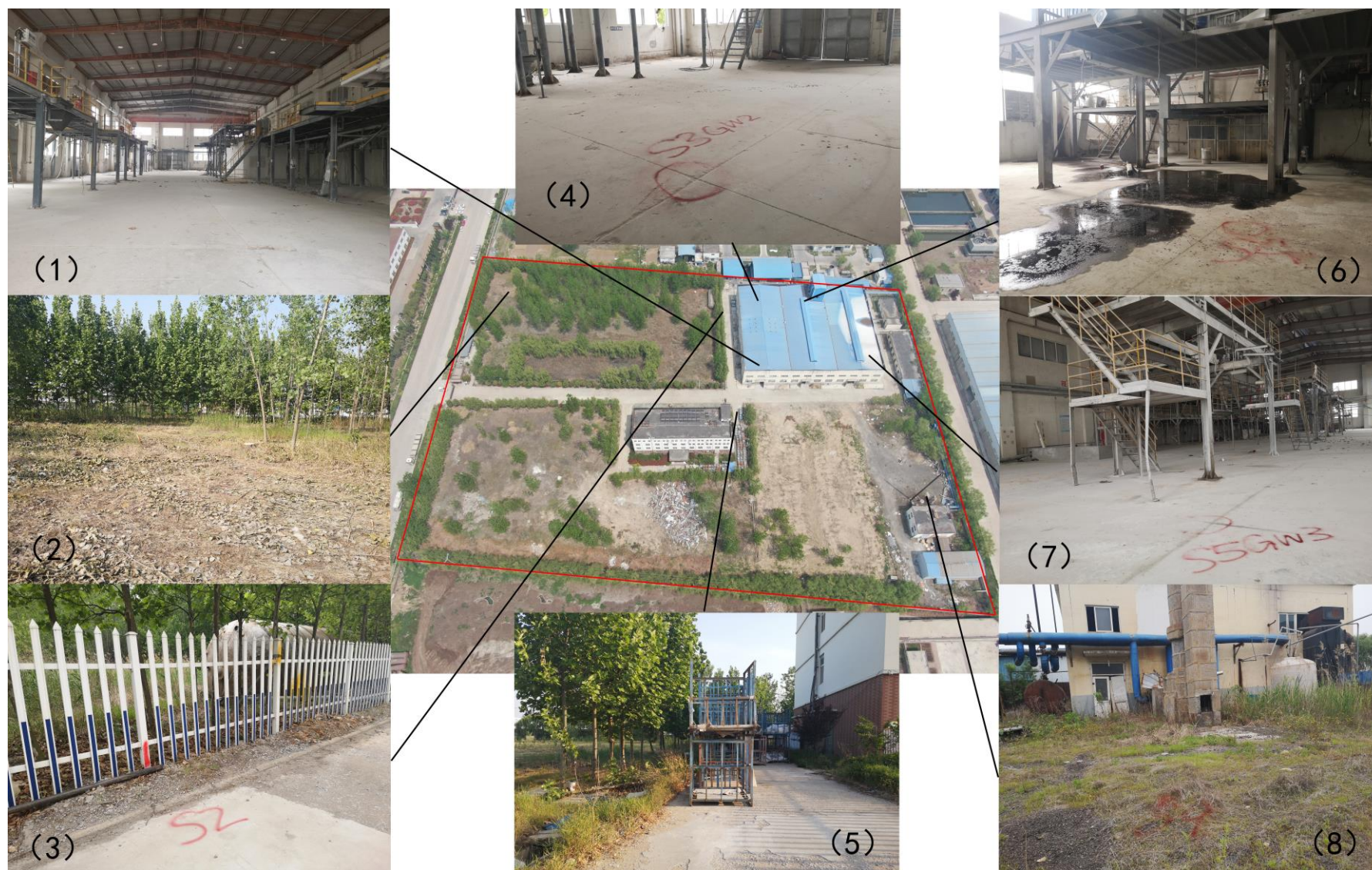
图 4.1-1 现场踏勘照片
